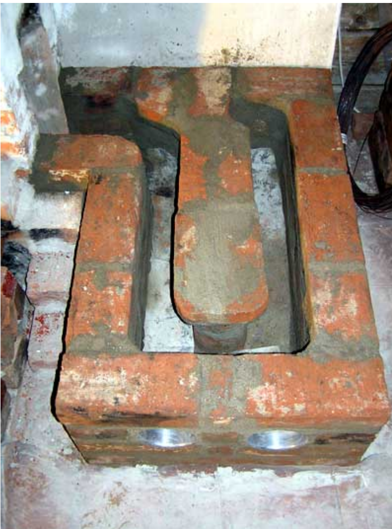
4. kerros. Savukanavien päälle muurattu tiilet, joiden alareunat on pyöristetty. Muodostuu sieni, T-kirjain.
