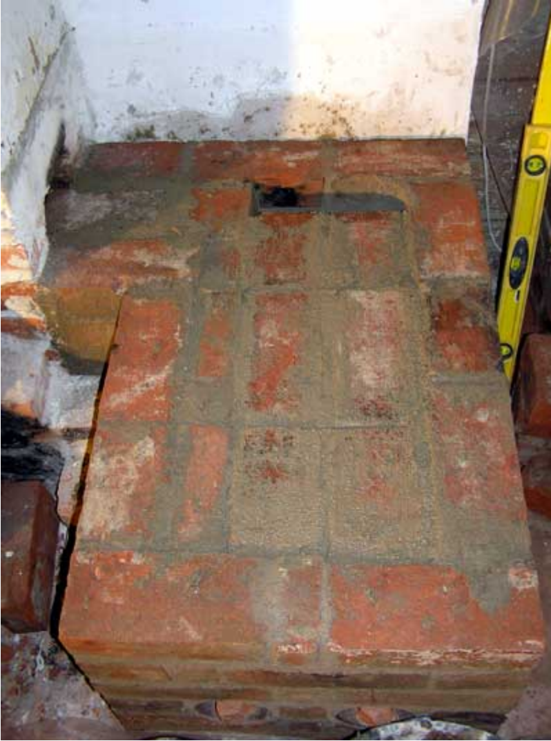
6. kerros. Muurattiin toinen umpikerros päälle.
