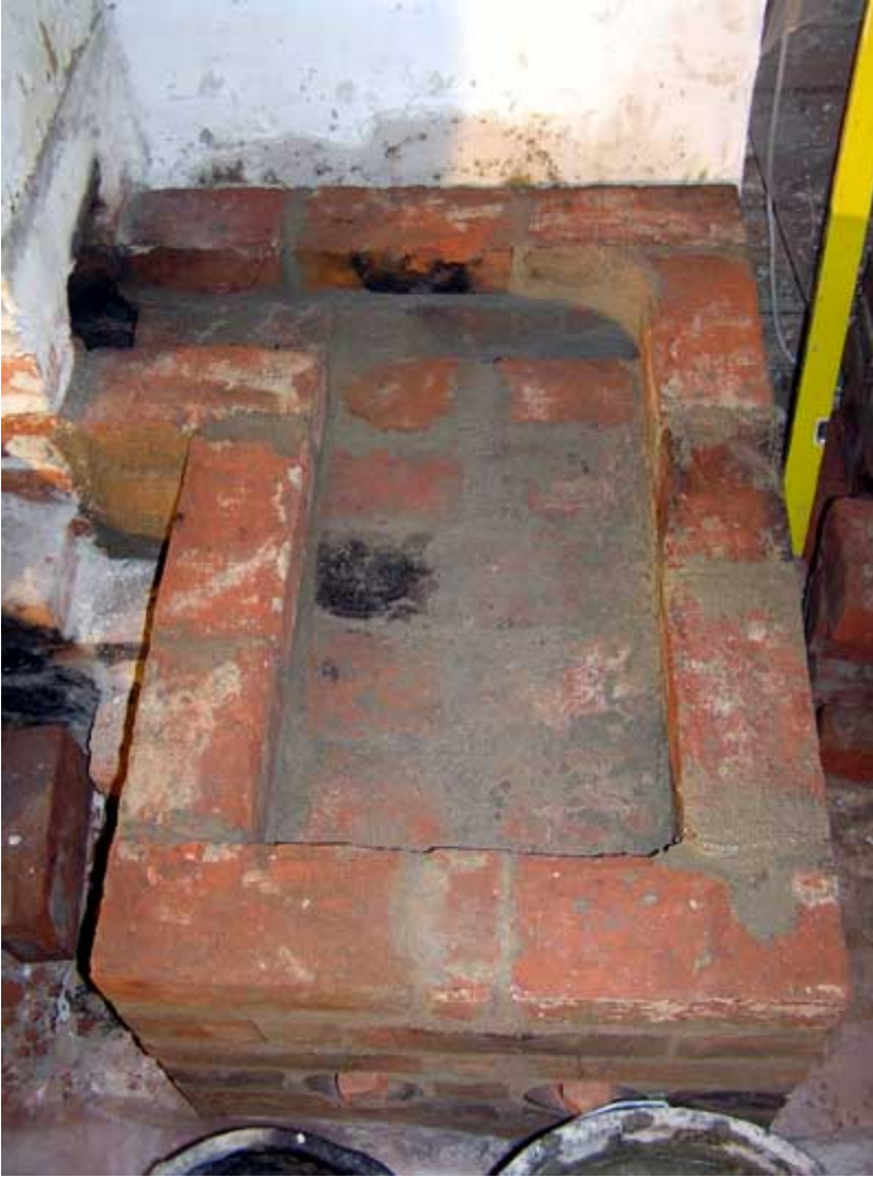
5. kerros. Muurattiin kansi päälle. Mitään rautoja ei tarvittu. Oikeassa takakulmassa näkyy tulevan pystyaukon muoto josta tuli liesitason alta kulkee savukanavaan. (6. kerros jo reunoilla)
