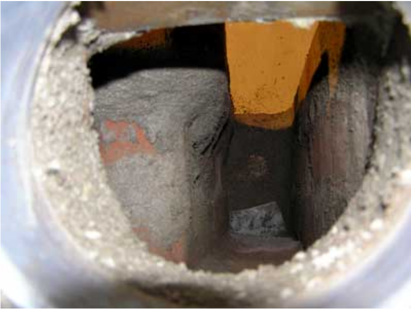
Uunin sisälle katsottuna oikeasta tarkistusluukusta.
